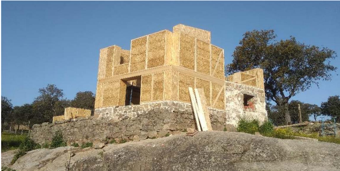
Imagen superior derecha: Entramado prefabricado de madera y corcho granulado. Imagen superior izquierda: Entramado prefabricado de madera y fibra de madera. Imagen superior: entramados prefabricados de madera y paja para rehabilitación-ampliación de construcción existente.
